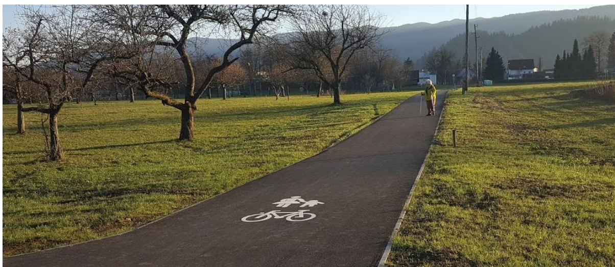
Slika 15: Mešana površina za pešce in kolesarje - navezava na kapelico.
