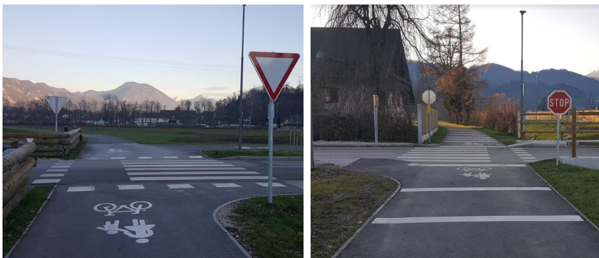
Slika 7: Otroci morajo biti pozorni pri prečkanju križišča na Kračci in Partizanski cesti.
