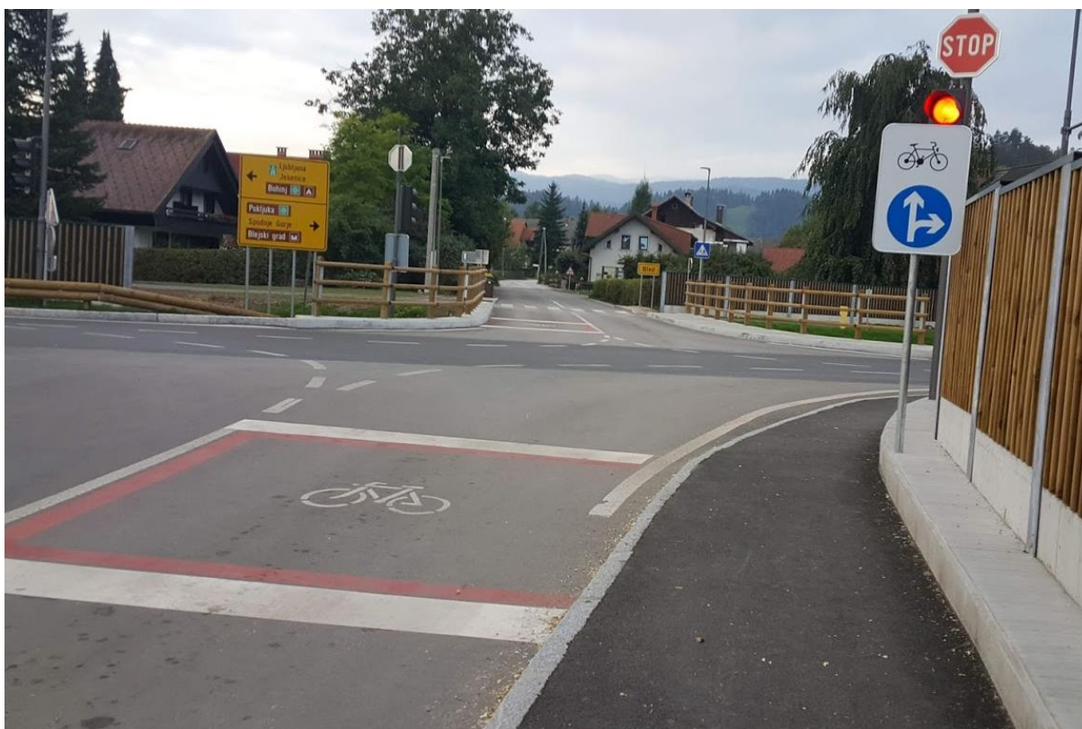
Slika 19: Križišče s severno razbremenilno cesto. Kolesarji čakajo na zeleno luč v kolesarskem boks, pešci s pritiskom na gumb počakajo na zeleno luč za pešce preko urejenega prehoda.
